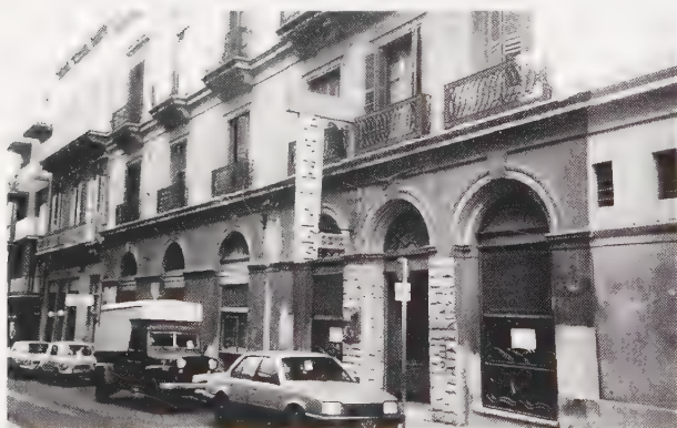
La chambre du Chancelier était au premier étage (fenêtre au-dessus de la camionnette en stationnement).
