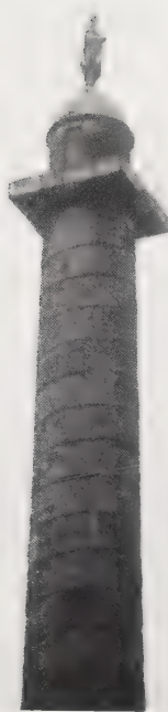
La colonne Vendôme : « Sur l'entablement de la colonne massive, appuyé contre la balustrade carrée, à plus de cinquante mètres de hauteur du sol un homme a lancé et déroulé un câble. »
